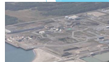
東通原子力発電所（東京電力）
