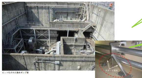
津波高さ: 約13m 津波最大波到達時刻: 15時29分 (地震発生から43分後)
