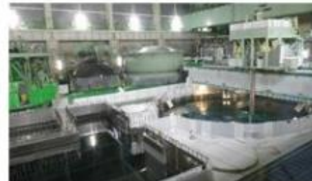
燃料装荷 (写真は原子炉に燃料集合体を挿入する作業の様子)
