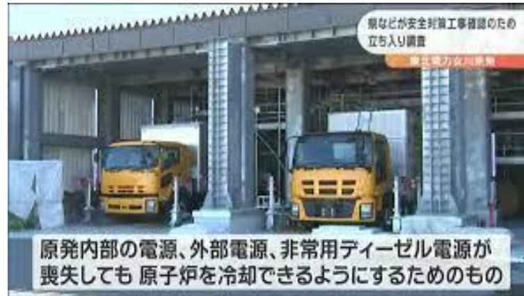
ガスタービン発電設備
