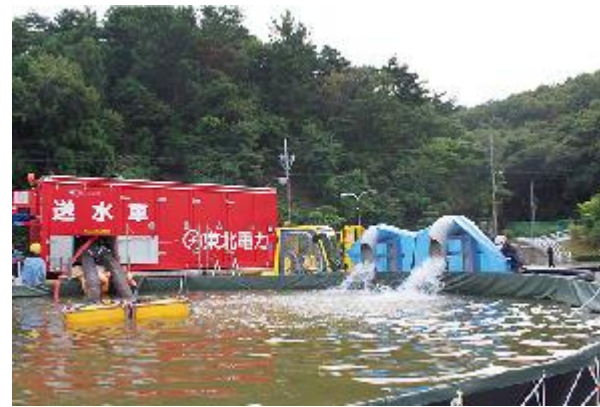
代替非常用冷却海水ポンプによる冷却機能確保訓練
